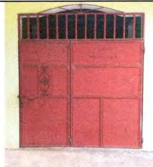
FOTO 22: Mantenimiento a estructura (lijado, cambio de tubo, cepillado, sujeciones, aplicación de pintura) a puertas servicios sanitarios
