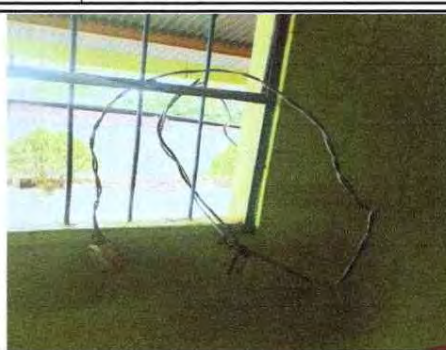
FOTO 8: Instalación de unidades fuerza (tomacorriente), incluye cable eléctrico
