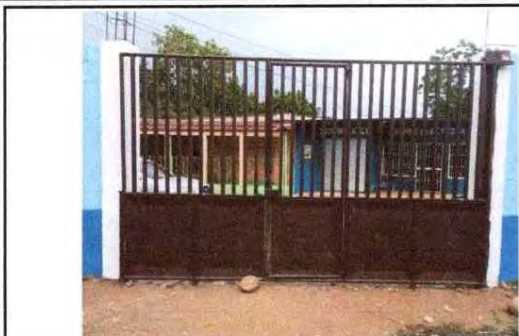
FOTO 19: Mantenimiento a portones de metal
