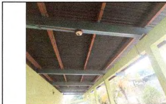
FOTO 2: Mantenimiento a estructura de soporte de metal
