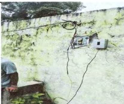
FOTO 9: Instalación de tablero y flípones
