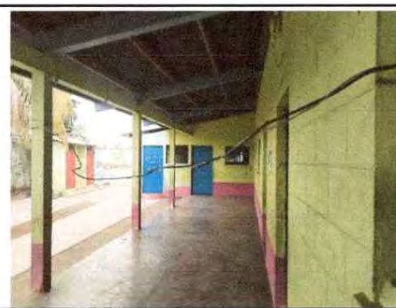
FOTO 10: Instalación de acometida eléctrica
