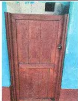
FOTO 13: sustitución de puerta de metal de baños
