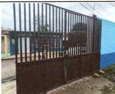
FOTO 11: Mantenimiento a portones de metal
