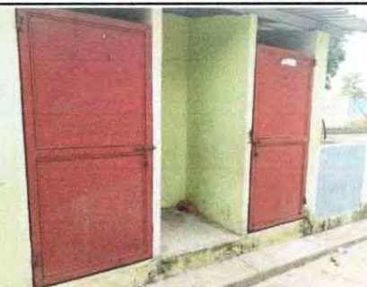
FOTO 12: Mantenimiento a estructura (lijado, cambio de tubo, cepillado, sujeciones, aplicación de pintura) a puertas servicios sanitarios
