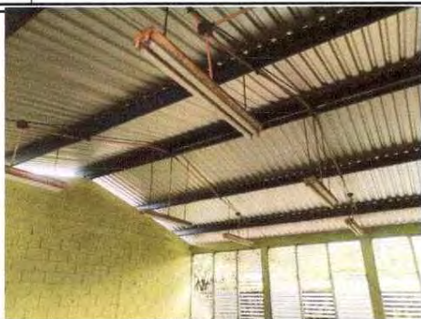
FOTO 7: Instalación de unidades luz (incluye interruptor, ducto y cable eléctrico)
