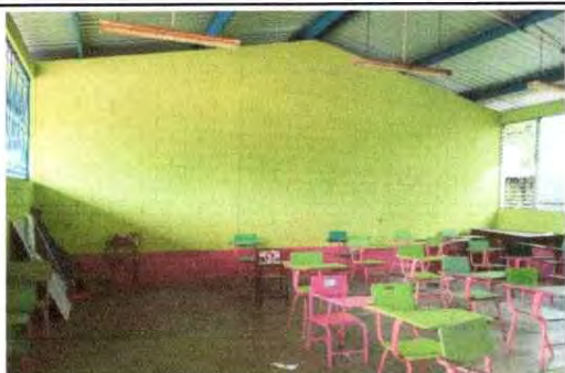
FOTO 21: Pintura en muros exteriores e interiores
