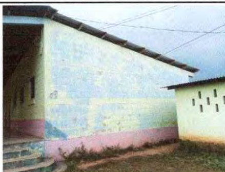
FOTO 20: Pintura en muros exteriores e interiores
