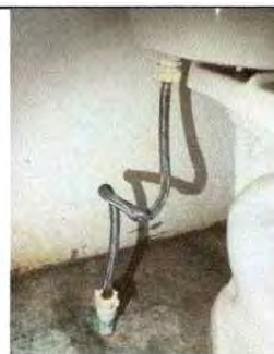
FOTO 17: Sustitución de accesorios inodoro (contra llave, tubo de abasto y tanque)
