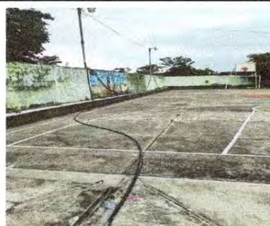
FOTO 14: Instalación de tubería para agua potable
