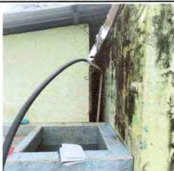
FOTO 15: Instalación de tubería para agua potable
