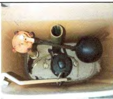
FOTO 17: Sustitución de accesorios inodoro (contra llave, tubo de abasto y tanque)
